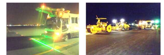
＜基本施設点検実施状況＞ ＜老朽化した滑走路舗装の改良＞
