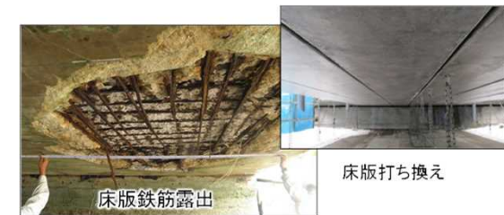
道路施設の老朽化対策
