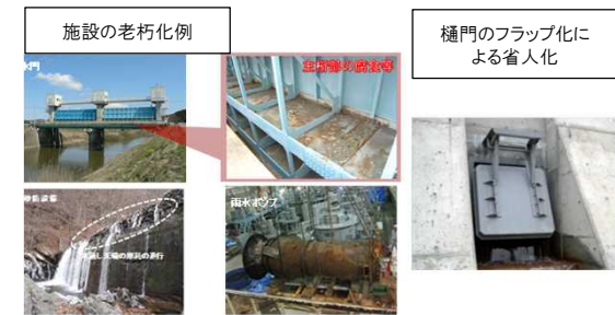
河川管理施設等の老朽化対策
